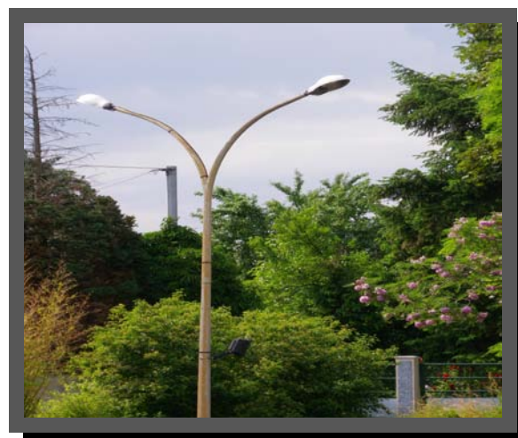
Éclairage supplémentaire sous le pont
