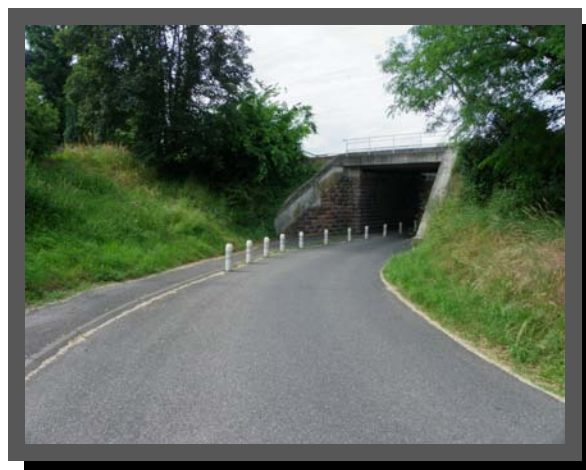
Plots à l'entrée du pont
